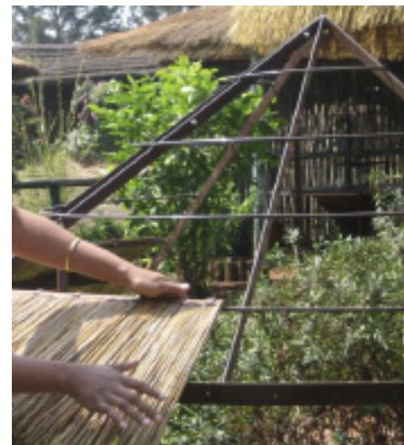
**Schritt 5:** Setzen Sie den Dachkegel außen auf den Rahmenfirst, gegebenenfalls mit einem Besenstiel. Bei großen Ausführungen können Sie den Dachkegel zunächst auf den Rahmen setzen und dann anheben, um die letzten Reetpaneele zu befestigen. Um den Kegel an Ort und Stelle zu halten, befestigen Sie ihn mit den hierfür vorgesehenen Seilen auf dem Rahmen.
