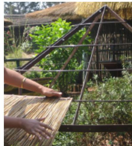
**Stap 5:** Plaats de dakkegel langs buiten op de nok van het frame, eventueel met behulp van een bezemsteel. Bij grote modellen kun je de dakkegel eerst op het frame plaatsen en hem optillen om de laatste rietpanelen te bevestigen. Om de kegel op zijn plaats te houden bevestig je hem op het frame met de touwen die hiervoor dienen.
